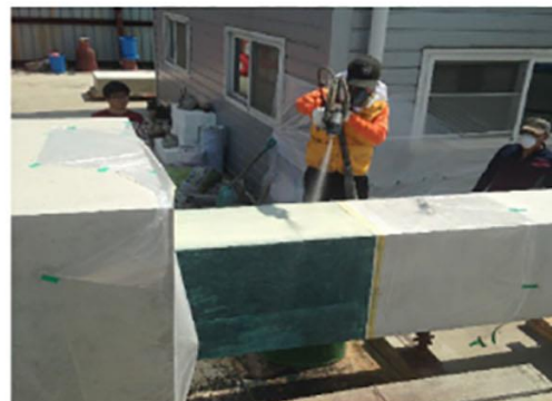
(d) Polyurea application process
