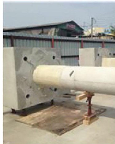
(b) PU Polyurea (STPU) coating applied
